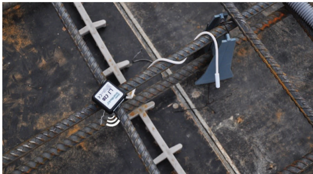
a) Before pouring
