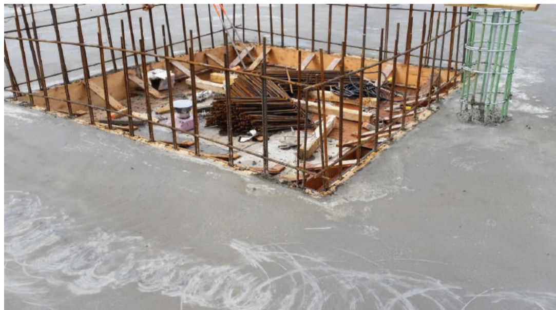
b) After pouring
